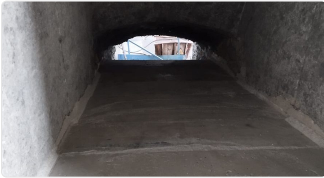
Kanal zwischen zwei Ofenräumen: Querschnitt auf Sollmaß
