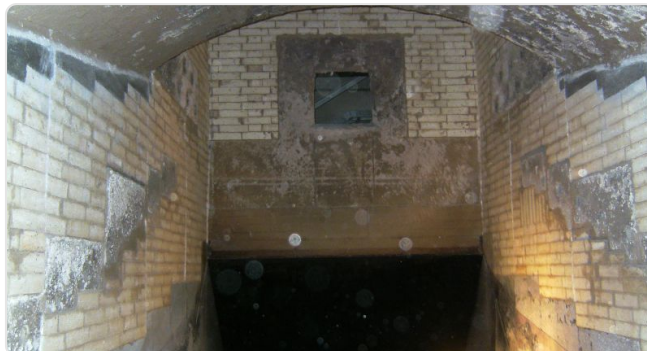
Ceneri e scorie attaccano chimicamente e meccanicamente
