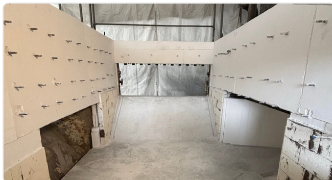
Ancoraggi nel rivestimento della suola
