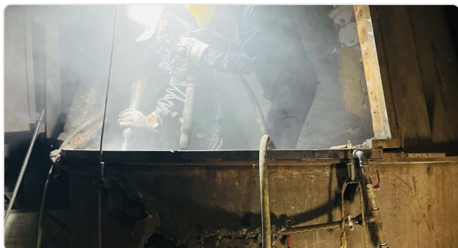
Pulizia e demolizione prima del rivestimento
