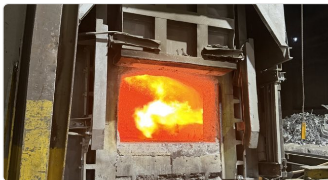
Rifacimento completo del rivestimento con lavoro a turni
