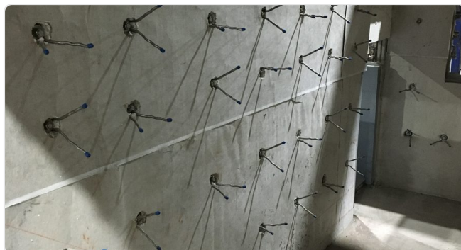
Ricostruzione: ancoraggi a griglia su un nuovo strato isolante
