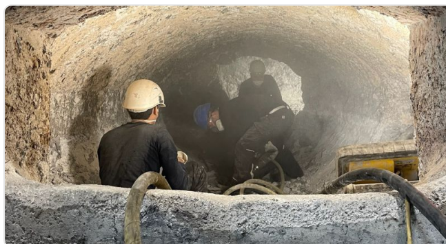
Gunitatura di manutenzione durante il turnaround
