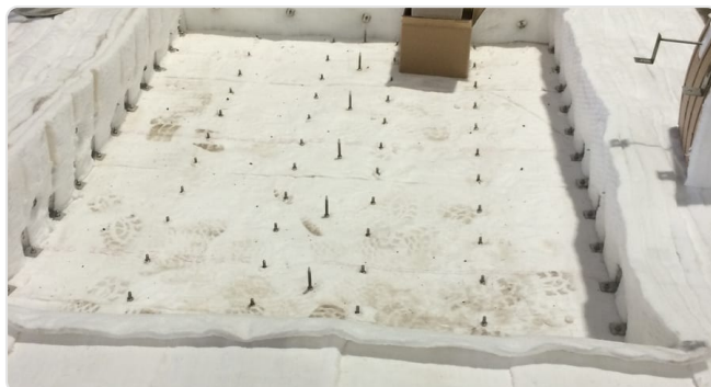
Griglia di ancoraggi nel telaio del coperchio prima della colata
