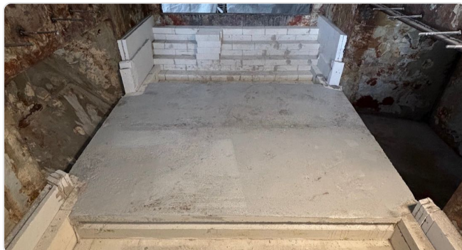
Rivestimento della suola con cassaforma
