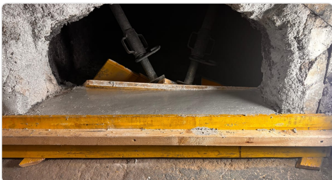
Bocca di carica: nuova suola su cassaforma, contorno demolito a spigoli vivi
