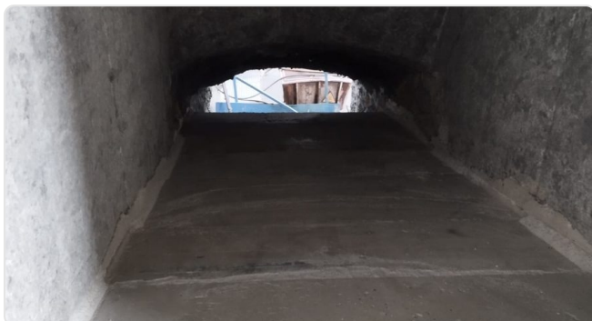
Canale tra due camere del forno: sezione alla misura nominale
