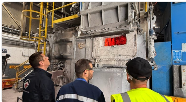
Valutazione dello stato durante il fermo impianto
