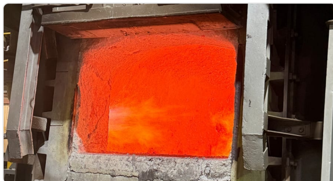
Rivestimento incandescente in esercizio
