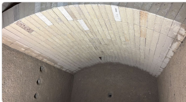
Nuova volta nella camera di combustione
