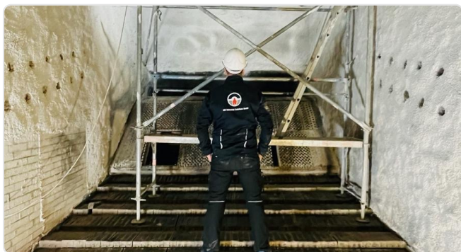
Rivestimento di un impianto di combustione a legna
