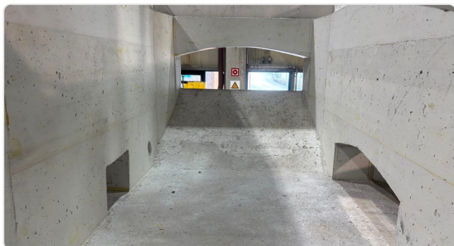
Camera del forno con nuovo rivestimento prima del primo riscaldamento
