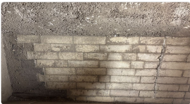
Transizione ammorsata a gradini, a destra il giunto di dilatazione
