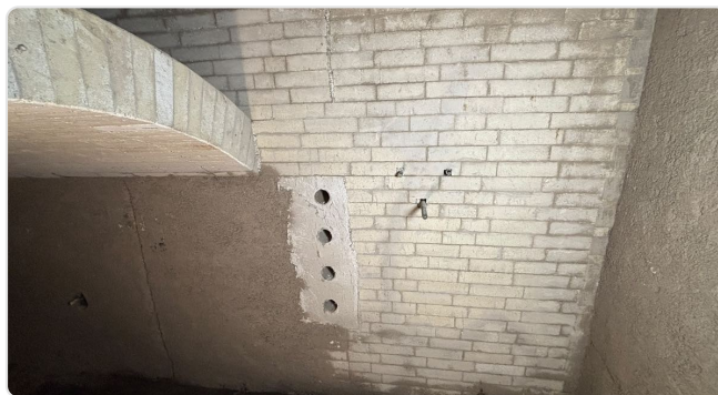
Aperture per l'aria secondaria realizzate durante la posa
