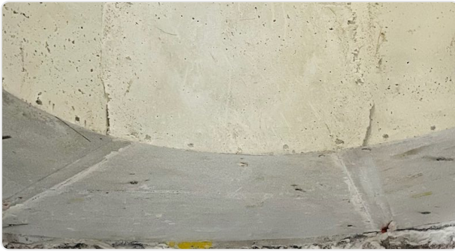
Fertige monolithische Auskleidung mit sauberen Anschlüssen
