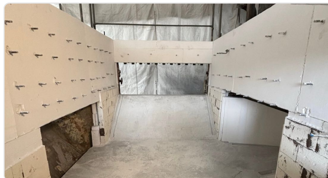
Ancrage dans le garnissage de sole
