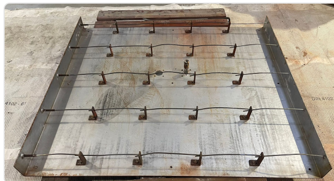
Remise en état de la porte et du couvercle
