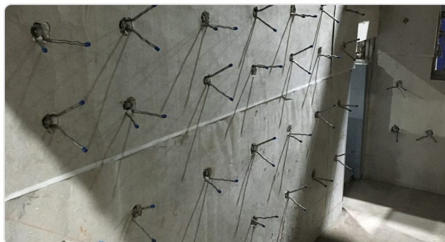
Reconstruction : ancrages posés selon une trame sur une nouvelle couche isolante
