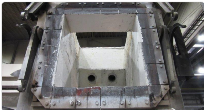
Lances de brûleur après remise en état
