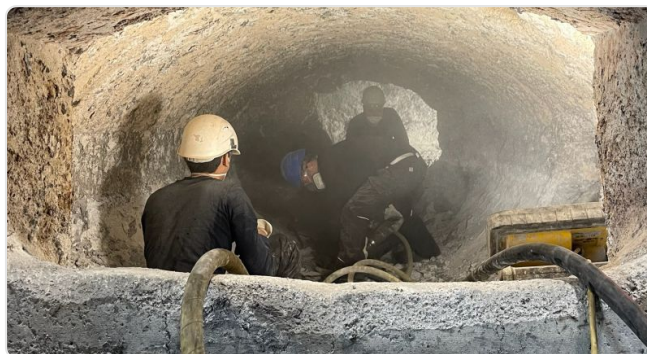
Gunitage d'entretien pendant l'arrêt de maintenance
