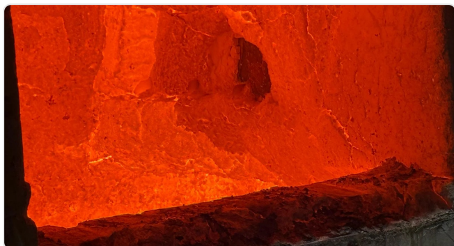
Réparation d'urgence sur un four à aluminium
