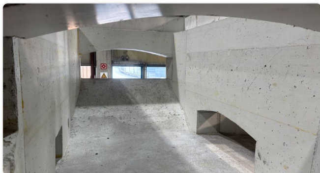
Coulée monolithique sans joints
