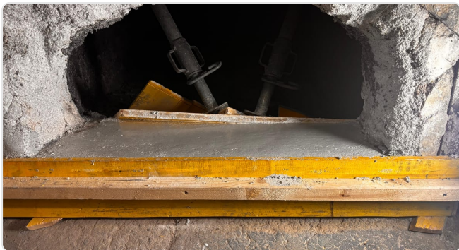
Ouverture de chargement : nouvelle sole sur coffrage, encadrement aux éclats anguleux
