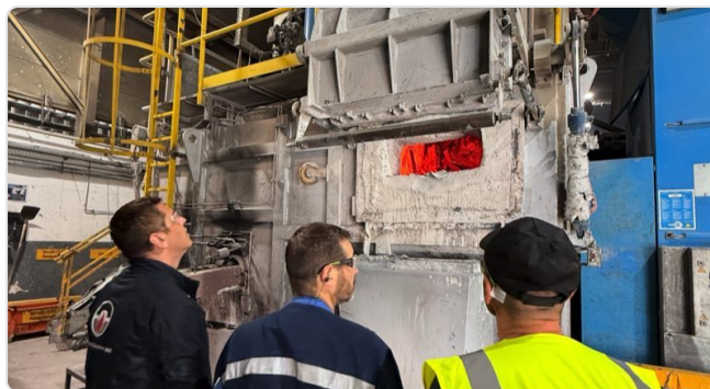
Inspection à l'arrêt
