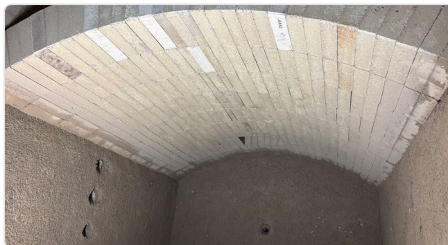
Nouvelle voûte dans la chambre de combustion
