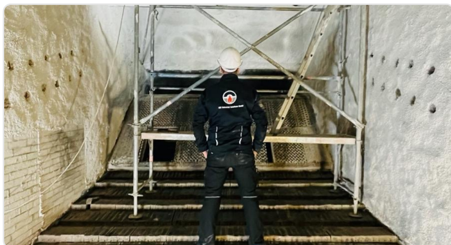
Garnissage d'une installation de combustion de bois
