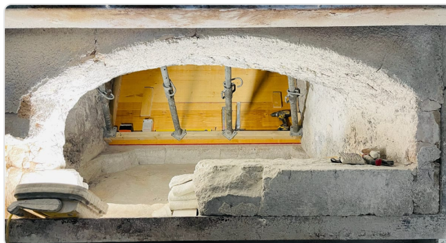
Ouverture du four nettoyée avant la reconstruction
