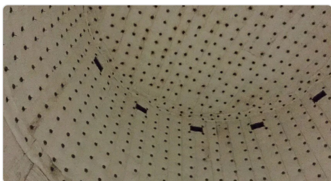
Isolation en fibre biosoluble pour la barrière thermique
