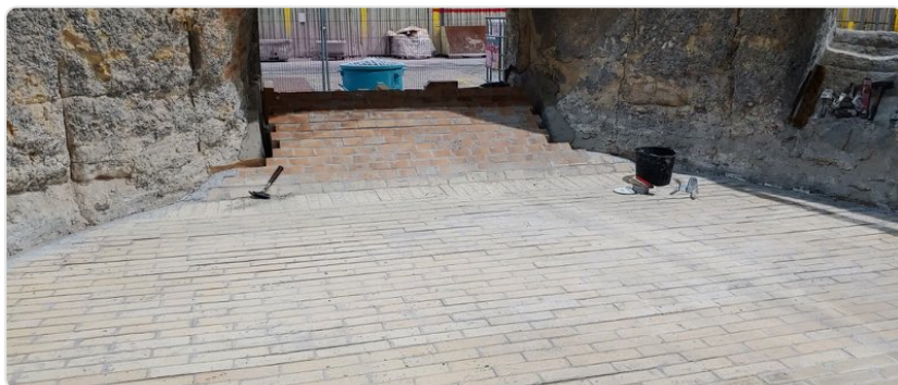
Zone de four fraîchement garnie avant la montée en température maîtrisée
