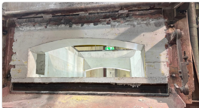
Façade du four : ouverture et porte adaptées à la nouvelle géométrie
