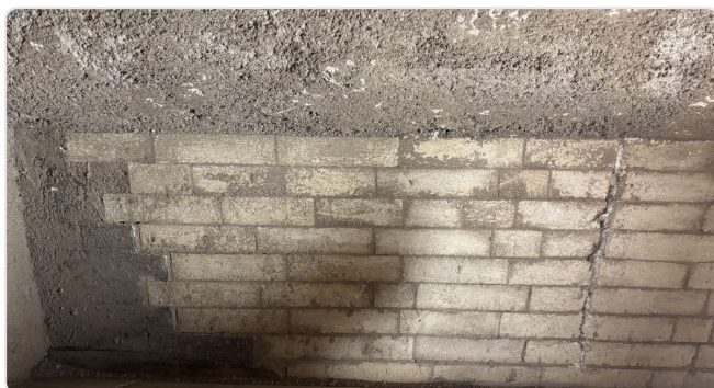
Transition imbriquée en escalier, à droite le joint de dilatation
