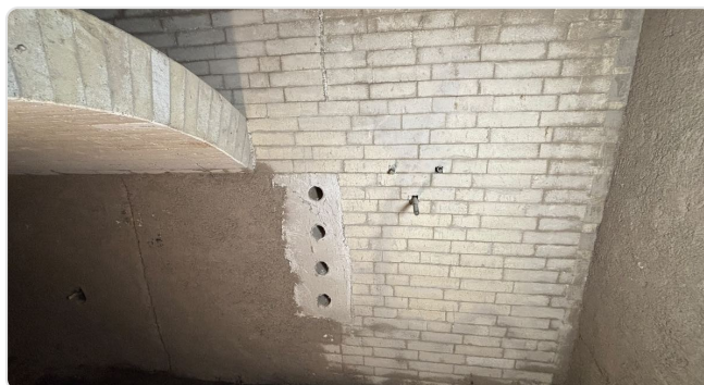
Ouvvertures d'air secondaire posées lors du montage
