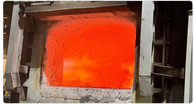
Glühende Zustellung im Betrieb
