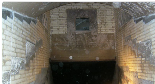
Las cenizas y la escoria atacan química y mecánicamente
