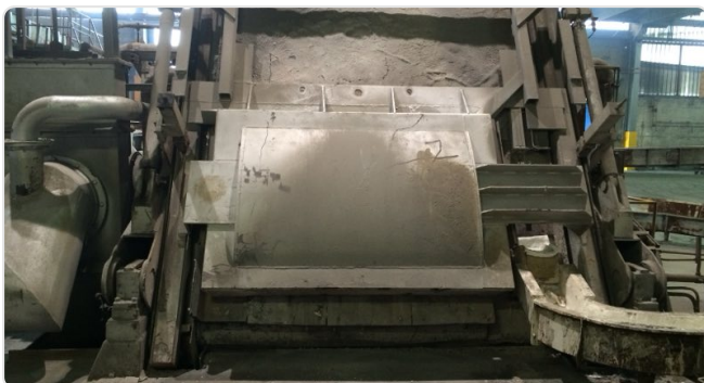
Campo de anclajes antes de aplicar la masa
