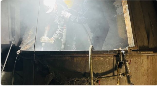
Limpieza y demolición antes del revestimiento
