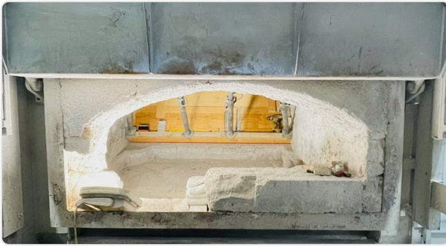
El arco solo aguanta si cada ladrillo aguanta
