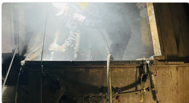
Revestimiento en un cubilote
