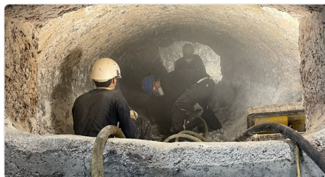
Gunitado de mantenimiento en el turnaround
