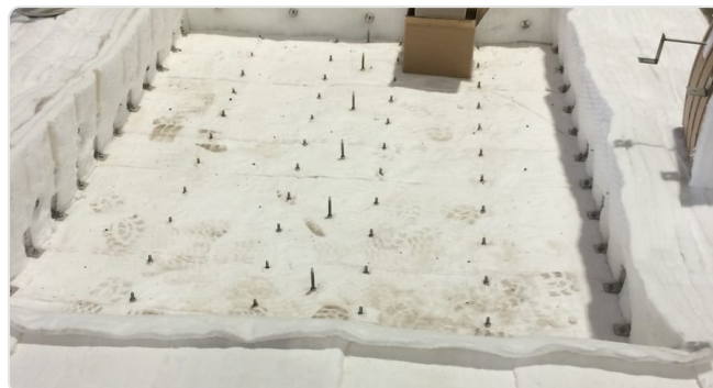
Retícula de anclajes en el marco de la tapa antes de la colada
