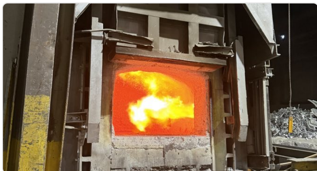
Nuevo revestimiento en trabajo por turnos
