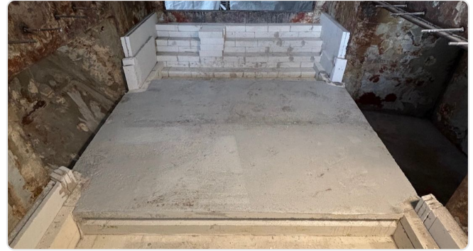
Revestimiento de la solera con encofrado
