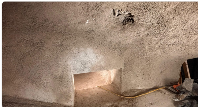
Pared y solera monolíticas en la zona de paso de la herramienta
