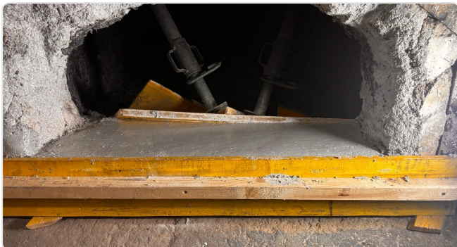
Boca de carga: nueva solera sobre encofrado, marco demolido en ángulo recto
