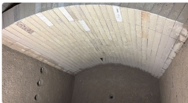
Nueva bóveda en la cámara de combustión
