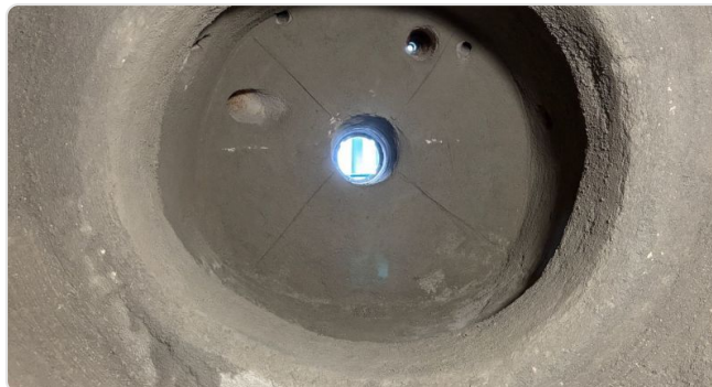
Junta de dilatación rellena correctamente con mantas de fibra
