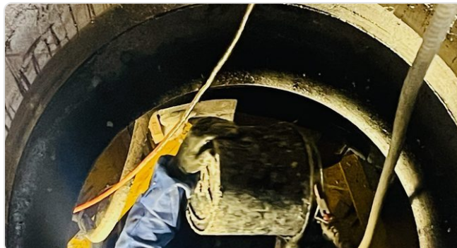
Acceso desde arriba: conducción y manguera por la misma abertura
