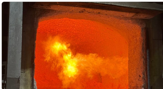
Superficie densa y con pocas juntas en la zona de la cuba
