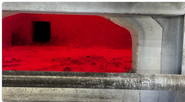
La línea de baño: la franja más solicitada del revestimiento
