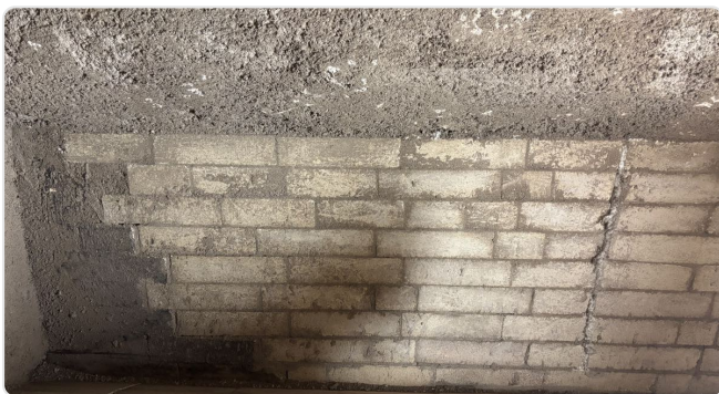
Transición dentada escalonada; a la derecha, la junta de dilatación
