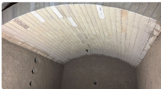
Neues Gewölbe in der Brennkammer
