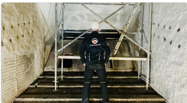
Zustellung einer Holzverbrennungsanlage
