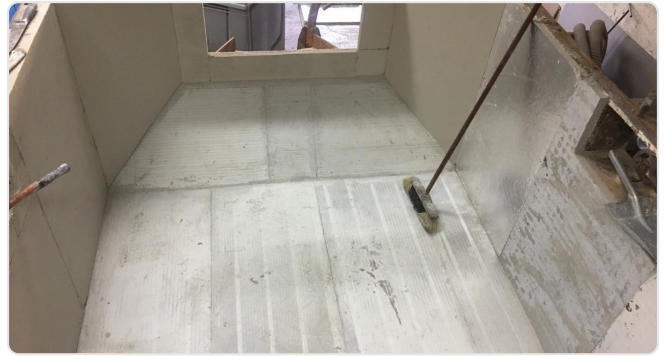
Zustellung mit vorgefertigten Formteilen
